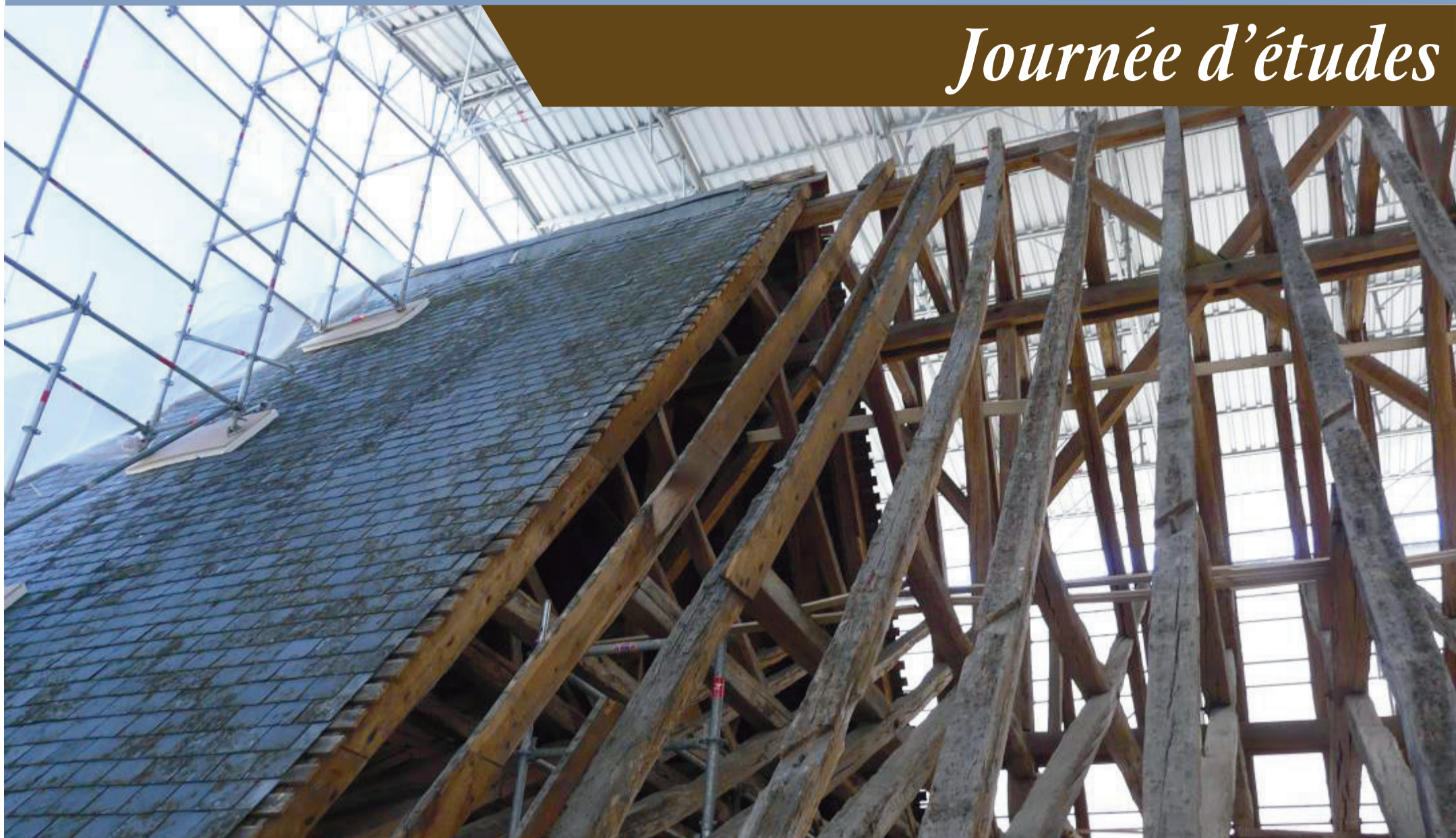
CHARPENTE ET TOITURE DE LA CATHÉDRALE DE BOURGES EN COURS DE RESTAURATION
